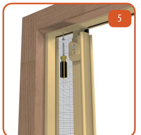
5 Fissare con le viti dal lato cassonetto le guide superiori.
